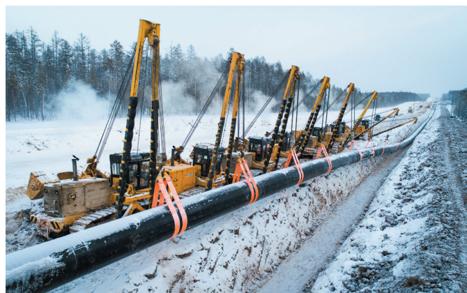
Строительство газопровода «Сила Сибири»
